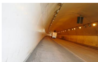
野尻トンネル
